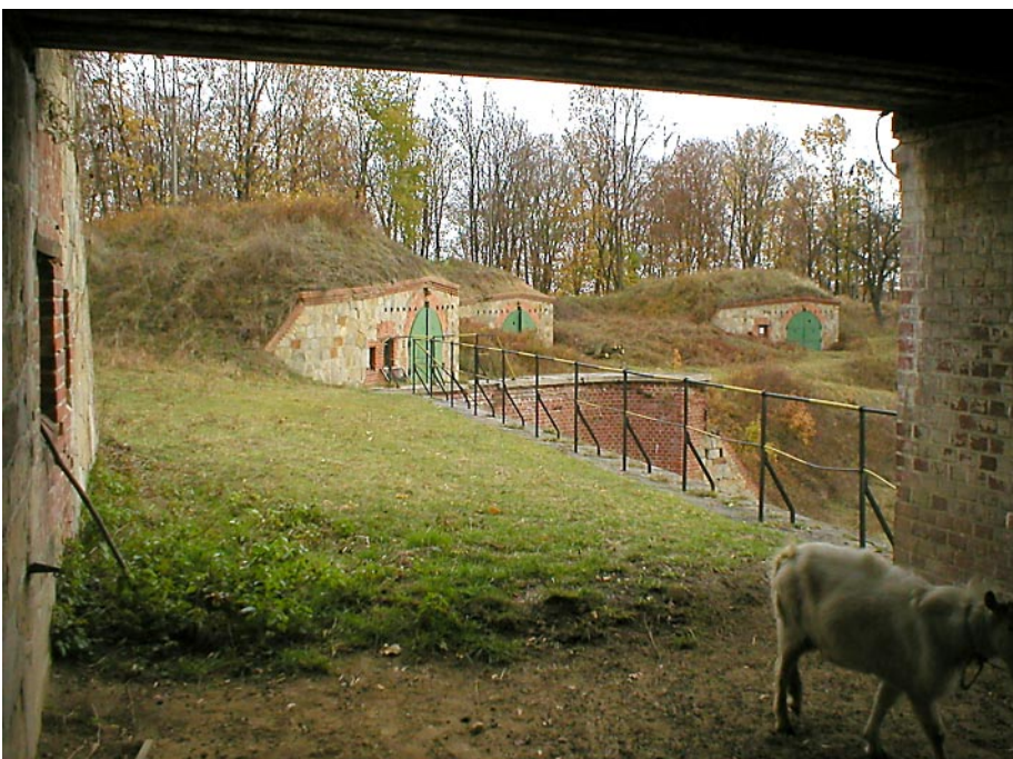
● Fort II, korona wału z kazamatami do przechowywania i obsługi dział
