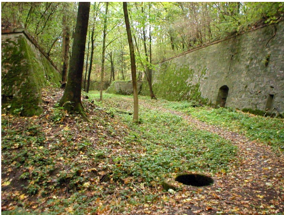
● Fosa fortu Prusy, po prawej wejście do galerii strzeleckiej w konter-eskarpie
